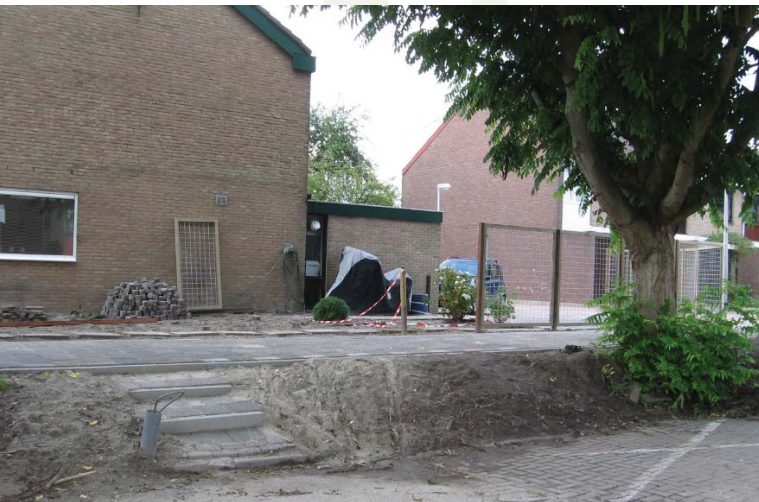
Door niet alle grond evenveel op te hogen, kon de boom rechts worden gespaard.
